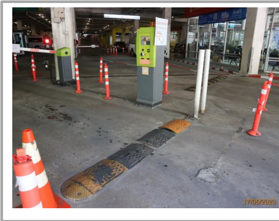
รูปที่ 3.1-7 แถบชะลอความเร็ว (Rumble Strip) ก่อนถึงทางเข้าออกโครงการ
