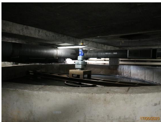
รูปที่ 3.1-20 บ่อดักตะกอน ระบบบำบัดน้ำเสีย แบบ Deep shaft
